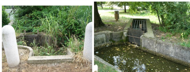
Paratoie lungo il Nova 4/A.
