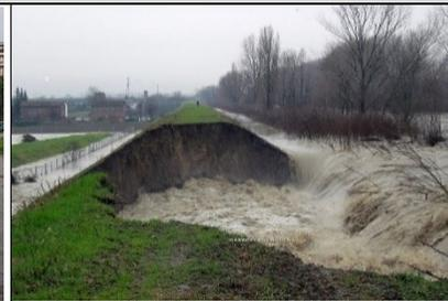
Rottura arginatura canale – Prov. Di Modena –
