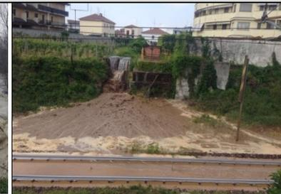
Rottura arginatura canale e allagamento ferrovia
