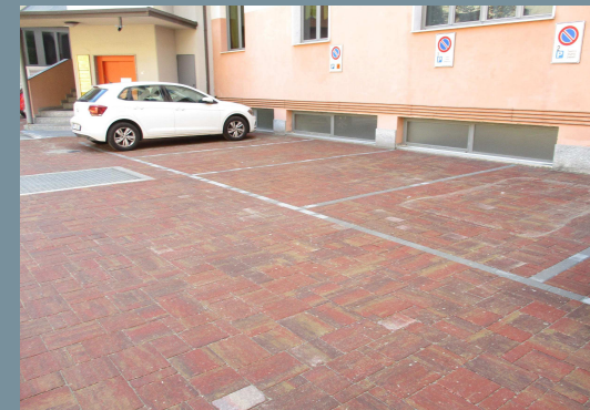
Pavimentazione Via I Maggio
