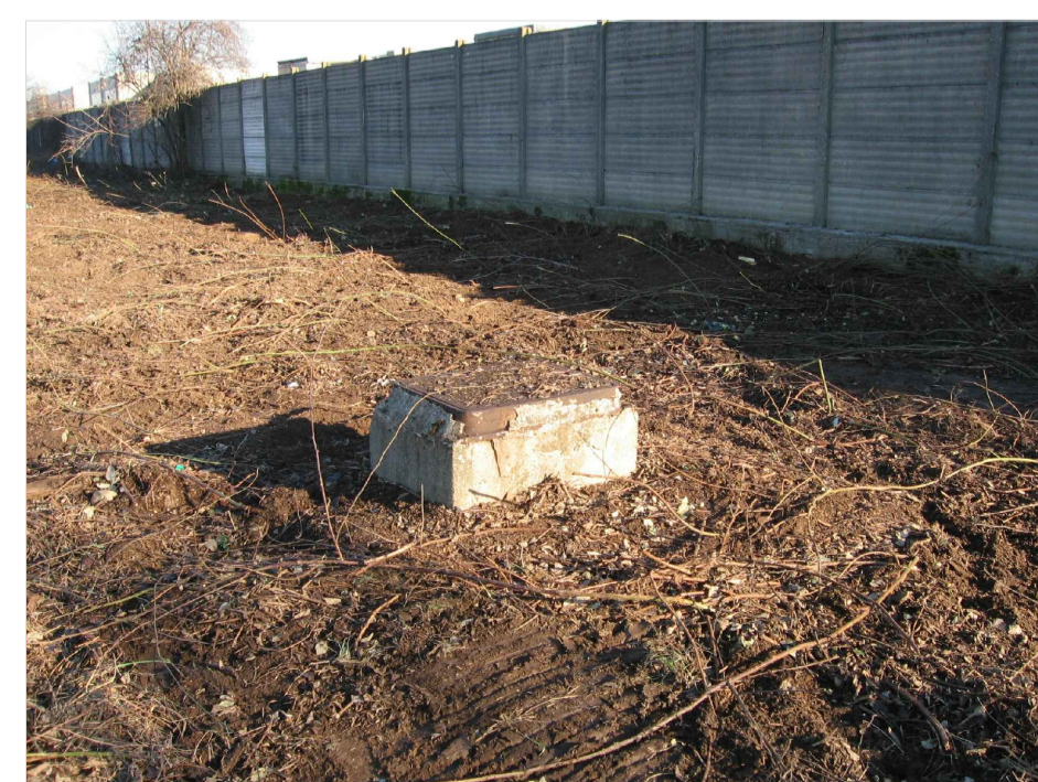
RILEVAZIONE FOTOGRAFICA DELLE CAMERETTE DI CONDOTTA FOGNARIA INTERNA ALL' AMBITO DI INTERVENTO CON PROVENIENZA DA VIA FIGINI
