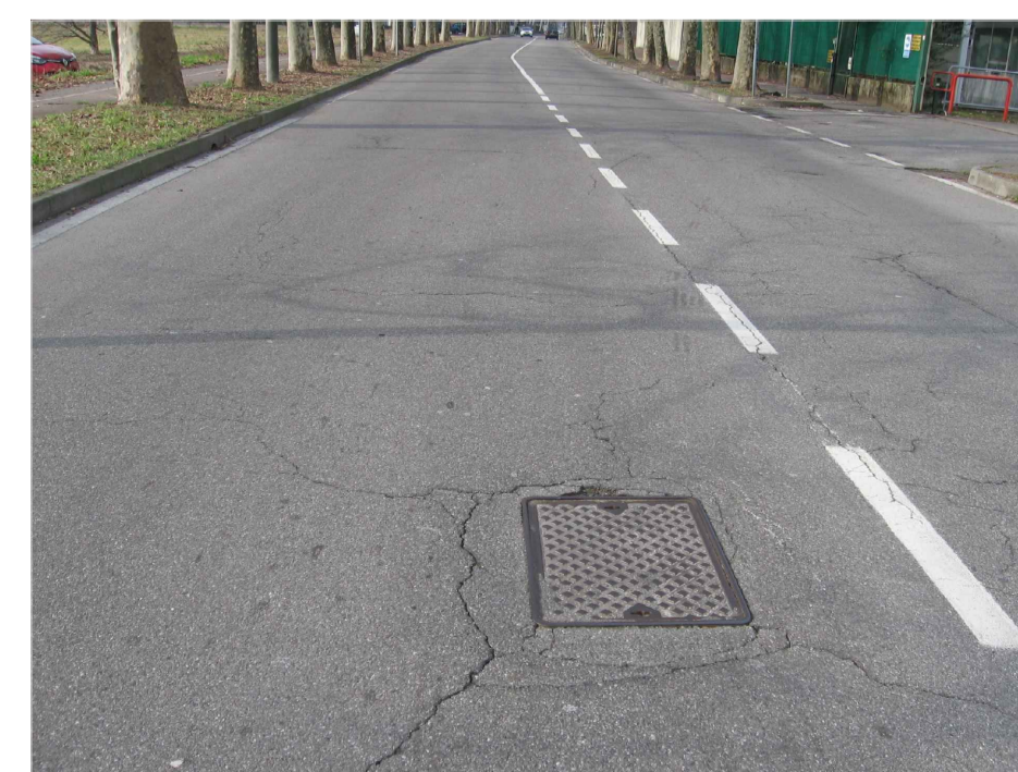
RILEVAZIONE FOTOGRAFICA DELLE CAMERETTE DI CONDOTTA FOGNARIA ESISTENTE SU VIA PAVIA
