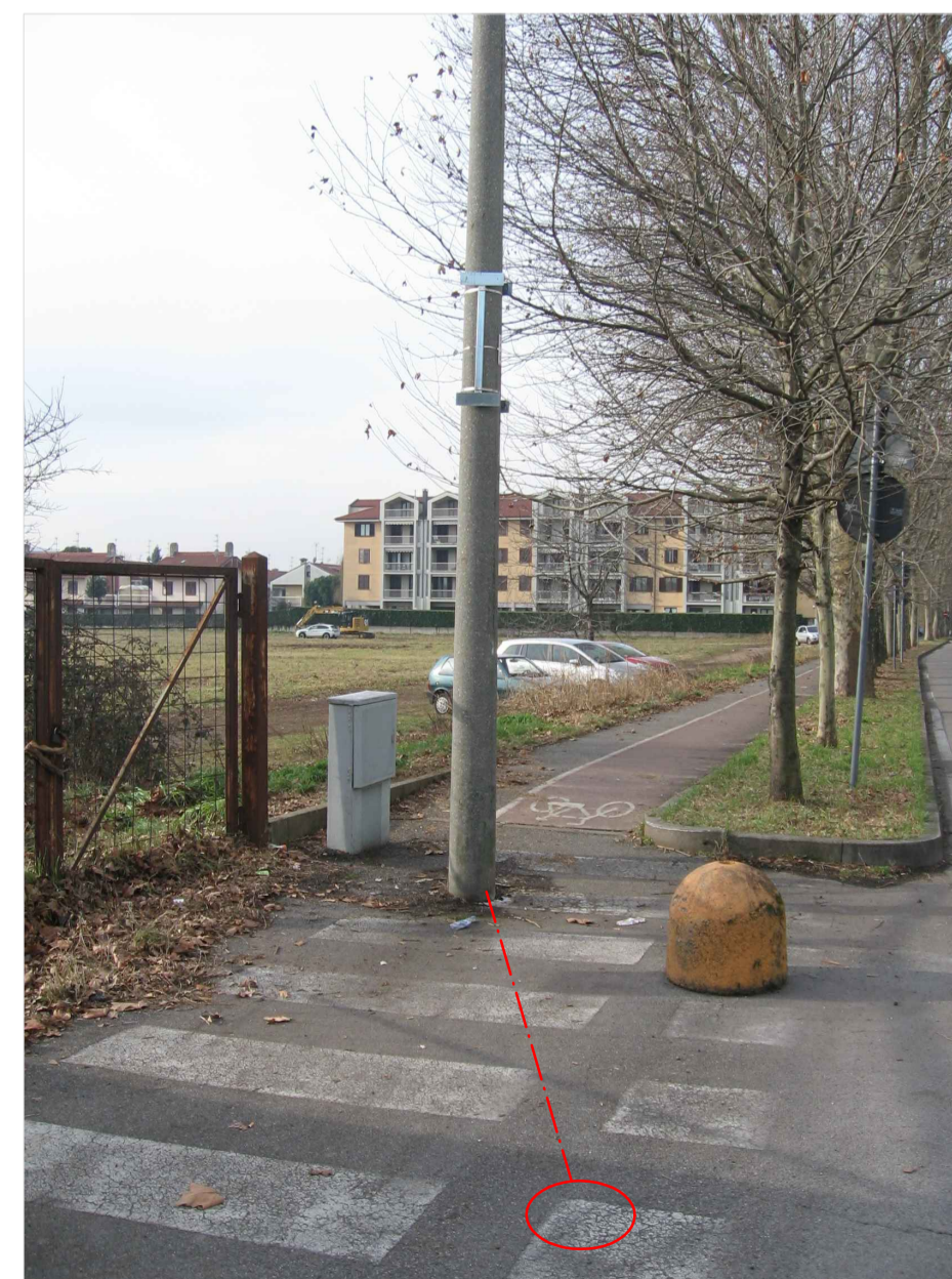
PALO DI ILLUMINAZIONE PUBBLICA DA SPOSTARE SU VIA PAVIA
